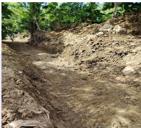
ÍTEM No. 19: EXCAVACIONES VARIAS SIN CLASIFICAR
