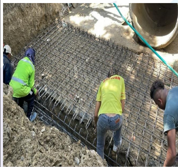
ÍTEM No. 17: ACERO DE REFUERZO DE 60.000 PSI
