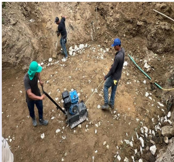
ÍTEM No. 5: RELLENO PARA ESTRUCTURAS (MATERIALES GRANULARES TIPO SUBBASE)
