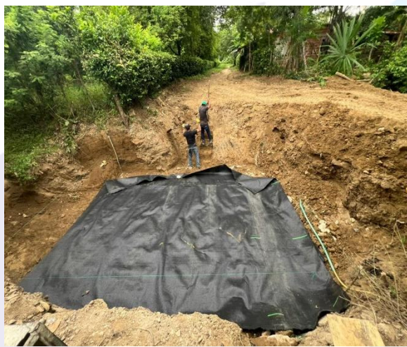
ÍTEM No. 9: SEPARACION DE SUELOS DE SUBRASANTE Y CAPAS GRANULARES CON GEOTEXTIL
