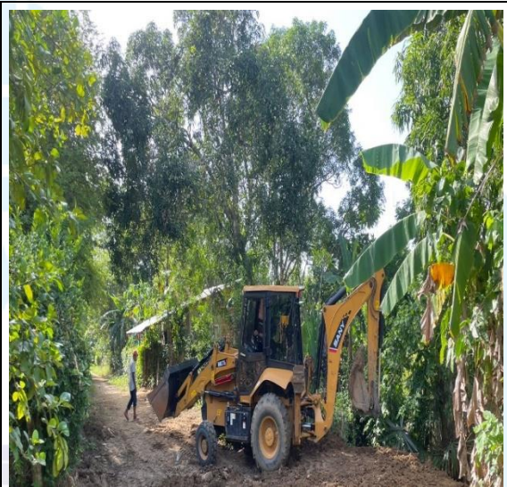
ÍTEM No. 2: DESMONTE Y LIMPIEZA
