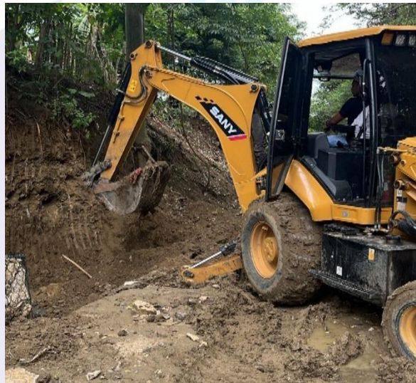
ÍTEM No. 14: EXCAVACIONES VARIAS SIN CLASIFICAR
