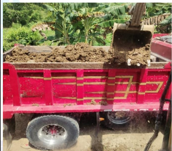
ÍTEM No. 20: RETIRO DE MATERIAL DE EXCAVACIONES HASTA LUAGAR AUTORIZADO MENOR A 5 KILOMETROS
