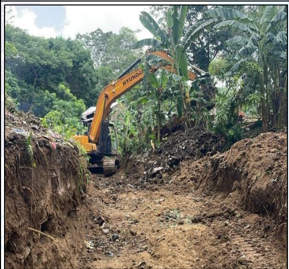
ÍTEM No. 4: EXCAVACIONES VARIAS SIN CLASIFICAR
